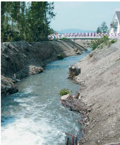
Abb. 11: Ausgebauter und renaturierter Gewässerabschnitt im Abschnitt Nord kurz nach der Fertigstellung. Fig. 11: Discharge improvement and re-naturalized river sector in section north shortly after construction.
