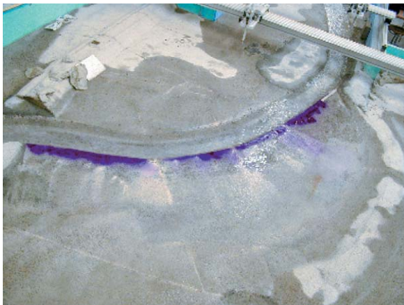
Abb. 7: Gleichmäßiges Überströmen des Streichwehres. Fig. 7: Regular overtopping of the side spillway.
