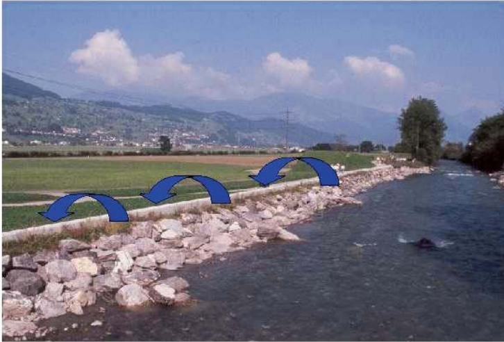
Abb 5. Notentlastung an der Engelbergeraa Fig. 5 Emergency spillway at the Engelbergeraa
