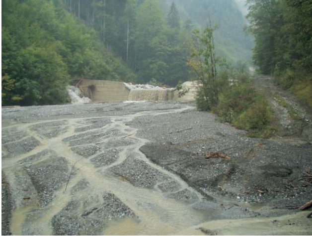
Abb. 4: Zwischendeponie von Geschiebe in einer Sperrstapelung nach einem Hochwasserereignis (Vorderberger Wildbach, Kärnten)
