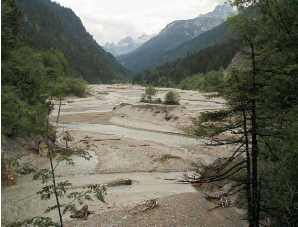
Abb. 3.: Entleerung des Verlandungsraumes der Geschiebestausperre im Hornbach im Rahmen des EU-Life Projektes Lech (Tirol)
