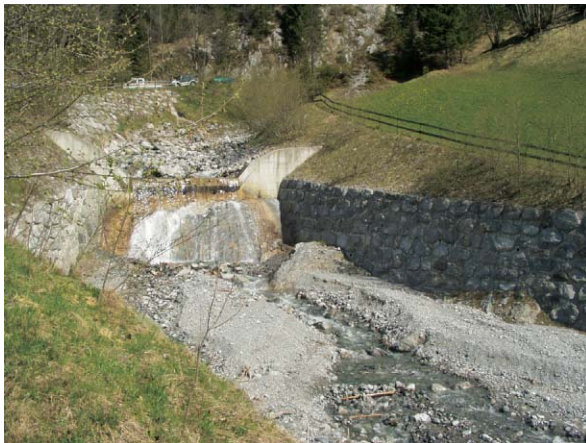
Abb. 3: Absturzbauwerk in einem Murbach in Klösterle (Vorarlberg).
