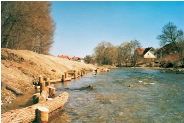
Abb. 7: Holzleitwände mit Ufersicherung aus Steinen Fig. 7: Wooden guide wall with stoned bank revetment
