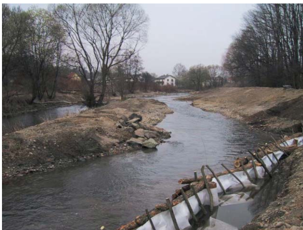
Abb. 9: Blick flussaufwärts während Baumsetzung Fig. 9: Upstream view before control measure
