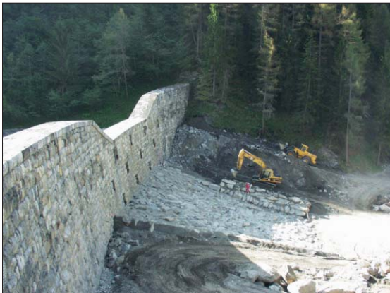
Abb. 3: Statische Sanierung der Kalkofensperre durch eine Vorschüttung
