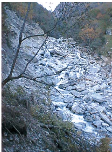
Abb4: Abgetragener Schuttkegel und Hanganriss Tuntschetta, Detailaufnahme Fig4: Eroded fan and valley flank at Tuntschetta. Detailed view
