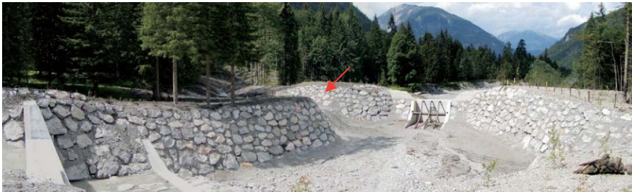
Abb. 4: Ausleitungsbauwerk hm 35,96 mit dem Retentionsraum und der Ausleitungsmulde (roter Pfeil) kurz nach der Fertigstellung im Frühjahr 2003.
