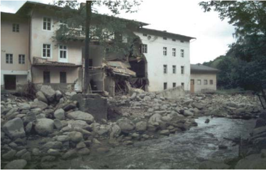
Abb. 1: Gebäudeschäden und Geschiebeablagerungen nach einem Abflussereignis (Wilczka-Einzugsgebiet, Schlesien/Polen, Juli 1997 Fig. 1: Damage to a building and depositions of bed load after a runoff event (Wilczka catchment area, Silesia/Poland, July 1997)
