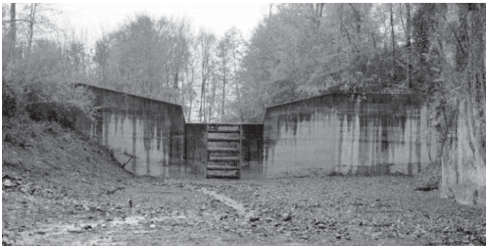
Abb. 1: Balkensperre als Abschlussbauwerk bei Geschiebesammler am Sigetsbach bei Sachseln (Kanton Obwalden).
