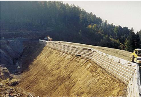
Fig. 1 Construction of the geotextile reinforced embankment at the toe of the mountain; Photo: M Scheibner ILF Abb. 1 Bau des Geokunststoff-bewehrten Dammes; Foto: M. Scheibner
