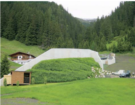
Fig. 4 Avalanche-protection wall Lanersbach, downhill view Abb. 4 Lawinenschutzmauer Lanersbach, Ansicht talseitig
