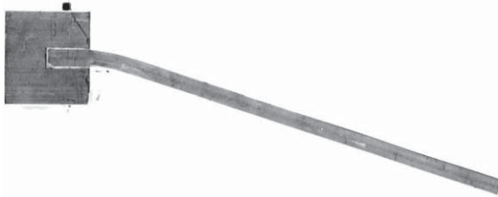
Fig.7: Fusible III.d.B après l'avalanche du 14-01-2003
