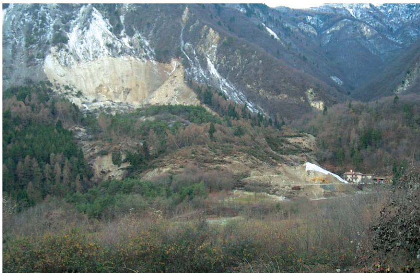
Fig. 1: Visione frontale della frana di Cima Salti durante i lavori di ripristino della viabilità (dicembre 2000).
