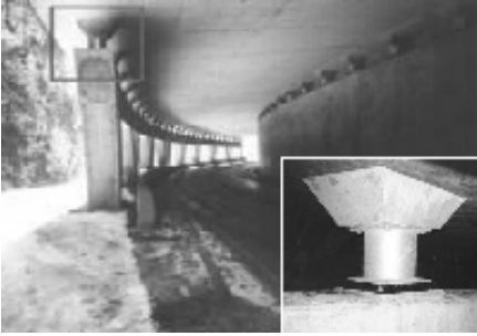
Fig.2 : Galerie Pare-bloc Structurellement Dissipantes à dalle horizontale Fig.2 : Structurally dissipative rock-shed with horizontal slab
