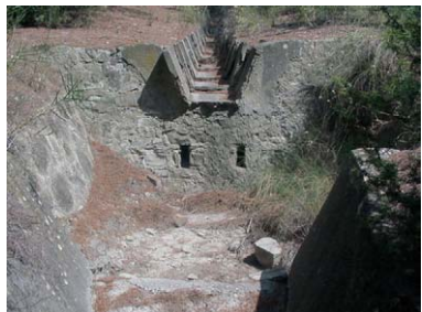
Fig. 7 - Briglia di ancoraggio in pietra e malta Fig. 7 - Stone masonry anchoring check dam
