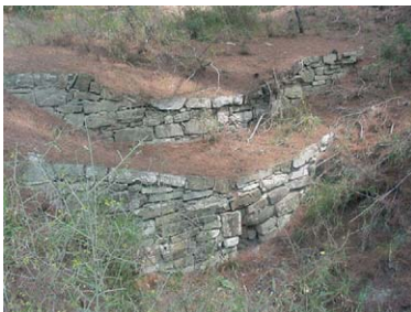
Fig. 6 - Briglia a doppia corda molle in pietra a secco Fig. 6 - Loose rock double sill
