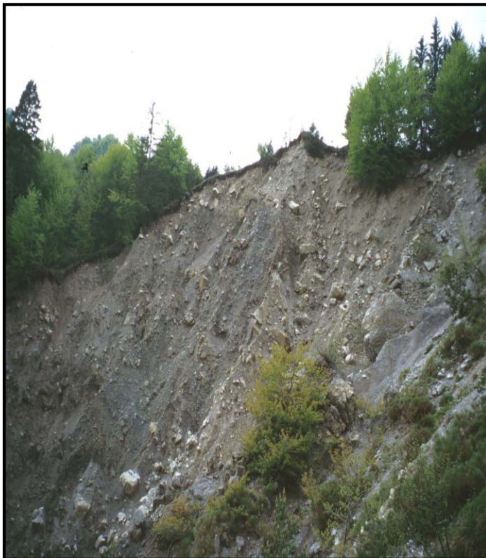
Fig3: Uno scorcio della testata della frana, prima degli interventi di consolidamento (1994)
