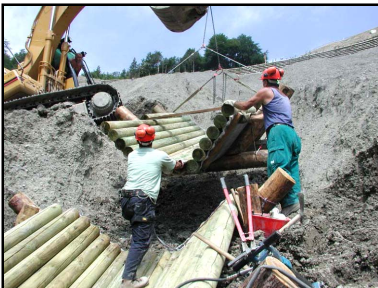
Fig7: Posa del drenaggio centrale Fig7: Laying of the “central drainage”
