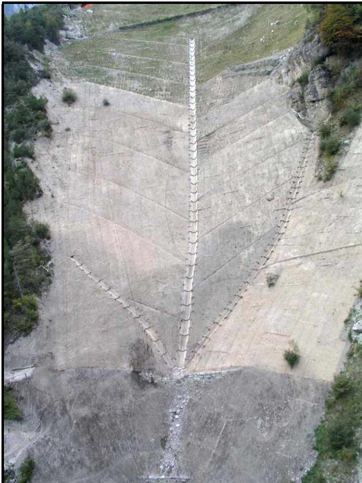
Fig6: Drenaggio centrale Fig6: The “central drainage”
