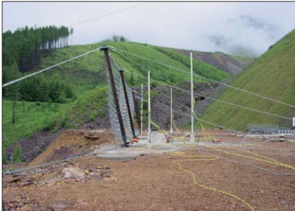
Abb3: Schutzverbauung auf Versuchsanlage Fig3: rock fall protection kit installed on test site
