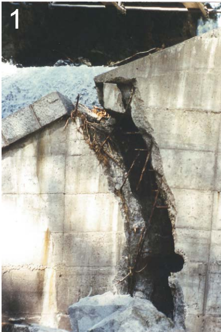
Abb3: Deutliche Rissbildung (Foto 1) und völlige Zerstörung (Foto 2) von Sperrenbauwerken am Talzuschub Gradenbach/Kärnten
