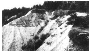
Abb. 3: Bau der Heckenbuschlagen in der Blaike Geroldsbach 1955
