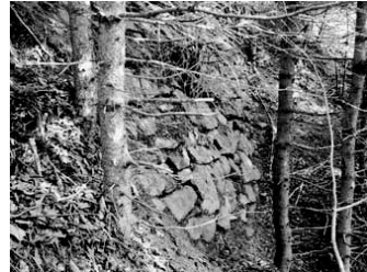
Abb. 10: Stabile Trockensteinmauer als Stützelement
