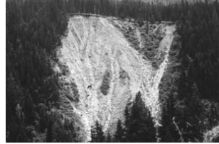
Abb. 1: Große Mure Enterbach vor der Stabilisierung 1952
