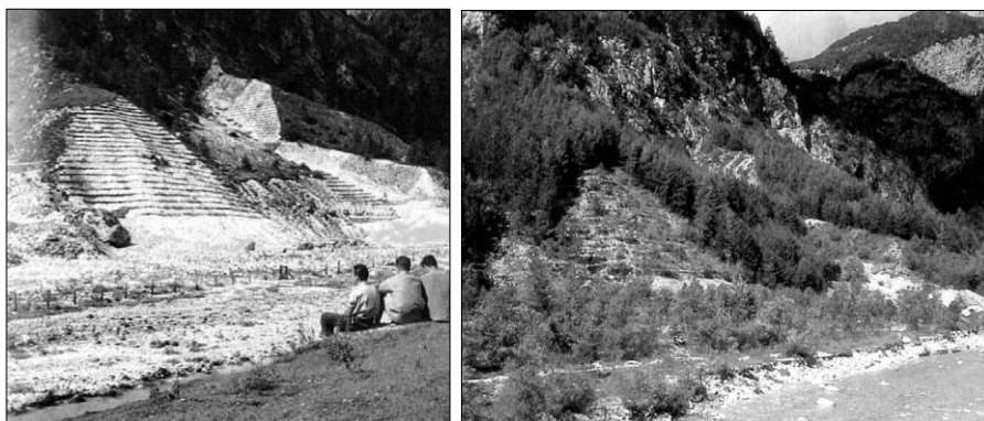
Abb. 6, 7: Stabilisierung rechter Hänge des Flusses Soča beim Dorf Log im Oberen Trenta Tal im Jahr 1957 und Zustand im Jahr 1994 (Foto: F. Rainer und M. Zemljčič)
