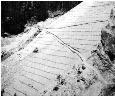
Abb. 13, 14: Wildbach Smeč – Böschungssicherung, nach den Rutschungen unter der Jureževo Alm, durch Heckenbuschlagen während des Bauausführung und drei Monate später. (Foto: F. Rainer)
