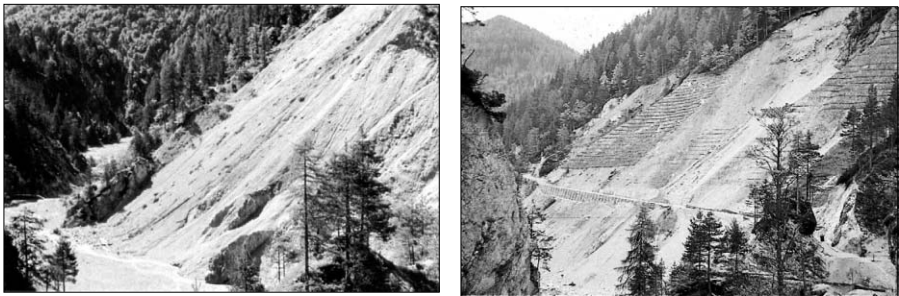
Abb. 8, 9: Großer Einbruch in oberen Lauf des Wildbaches Belca beim Zufluß Kurji graben - vor den Arbeiten (Jahr 1955) und in der Phase der Ausführung Sicherungsbauweisen (1962) (Foto: F. Rainer)
