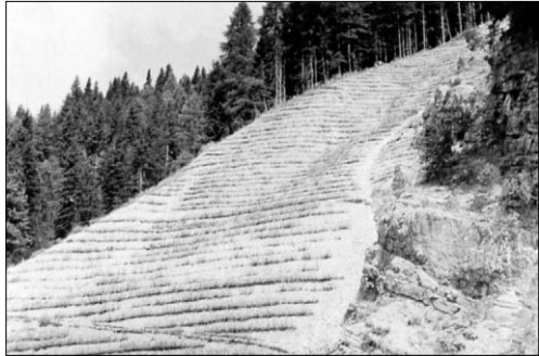
Abb. 13, 14: Wildbach Smeč – Böschungssicherung, nach den Rutschungen unter der Jureževo Alm, durch Heckenbuschlagen während des Bauausführung und drei Monate später. (Foto: F. Rainer)
