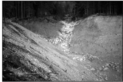
Fig. 10 e 11: sistemazione della zona d'innescio e di propagazione della colata con opere miste in massi e calcestruzzo armato.
