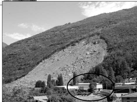
Fig. 7: Panoramica sul versante soprastante l'abitato di Bindo rispettivamente nel giugno 2001 e 2003. Fig. 7: Panoramic picture of side impeding on Bindo built-up area, on June 2001 and 2003.
