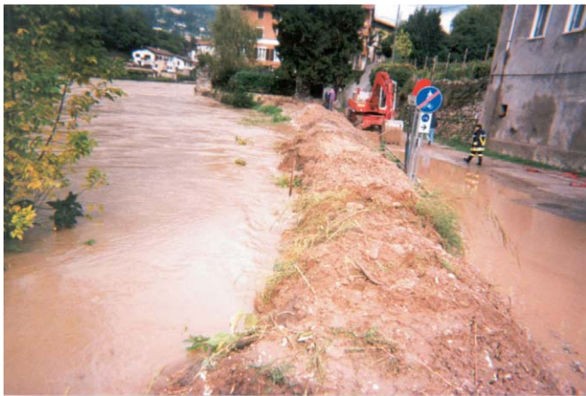
Immagine 6 - Argine provvisorio sul fiume Adige a Borgo Sacco (Rovereto) evento di piena ottobre 2000
