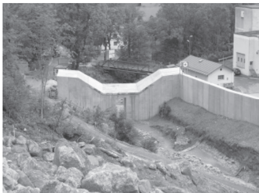
Abb. 9: Blick von Süden nach Norden auf die Schlitzsperre, die südlich von Immenstadt erbaut wurde Fig. 9: Photo in view of the open debris retention dam in the south of Immenstadt
