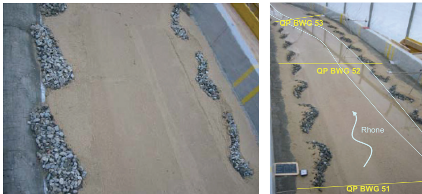
Abb. 8: Links: Blick flussaufwärts auf die Leitbauwerke in der Aufweitung Baltschieder. Rechts: Aufweitung Baltschieder nach einem 10-jährigen Hochwasserereignis mit Leitbauwerken als Uferschutz auf beiden Seiten. Dynamische Flussgestaltung mit alternierenden Sandbänken
