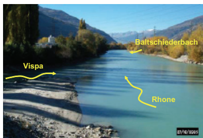
Abb. 2: Blick flussabwärts von der Vispamündung in den oberen Teil des Projektabschnitts
