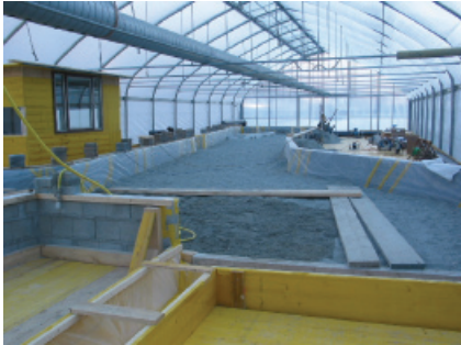
Abb. 4: Physikalisches Modell im Bau Fig. 4: Physical model under construction
