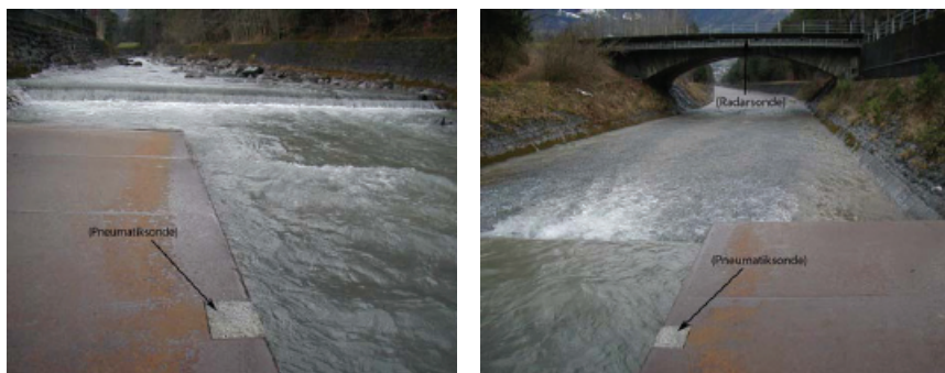
Abb. 1, 2: Abflussmessstation Schächen-Bürglen. Bild links: Blick gegen die Fliessrichtung mit Vorschwelle und Messgerinneeinbau (Pfeil: Profil Pneumatiksonde); Bild rechts: Blick in Fliessrichtung mit Messgerinneeinbau und zur Schächenbrücke, an der die Radarsonde montiert ist (Profil Radarsonde).
