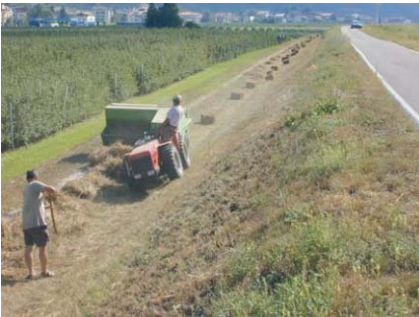
Abb. 10: Die Grasvegetation der Etschdämme wird abschnittsweise gemäht, dann wird das Mähgut abtransportiert Fig. 10: The grass vegetation on the dams of the river Etsch was mowed by sectors; afterwards the hay was carried away
