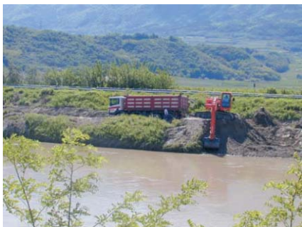
Abb. 5: Nachdem die dichte Baumvegetation entfernt wurde, transportieren Lastkraftwagen die mächtigen Anlandungen von Feinsand aus dem Flussbett (2002)
