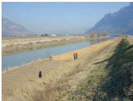
Abb. 6: Arbeiter befestigen Schilfsoden mit Stroh und Jutenetz
