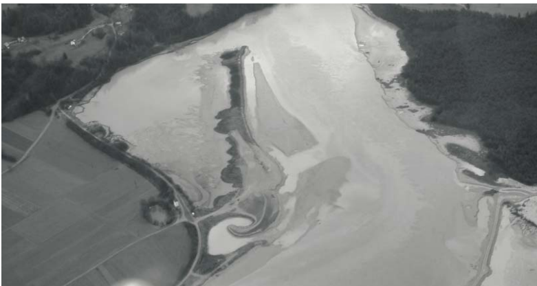
Abb. 9: Hochwasser November 2002 mit Teilabsenkung, Hafen und Zikkurat roh geformt, Luftbild
