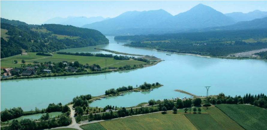
Abb. 4: obere Stauraumaufweitung im Bereich Selkach/Dragositschach im Jahr 2001, Luftbild, Blick flußab Fig. 4: Widening of storage basin in the area of Selkach/Dragositschach, 2001, view in downstream direction
