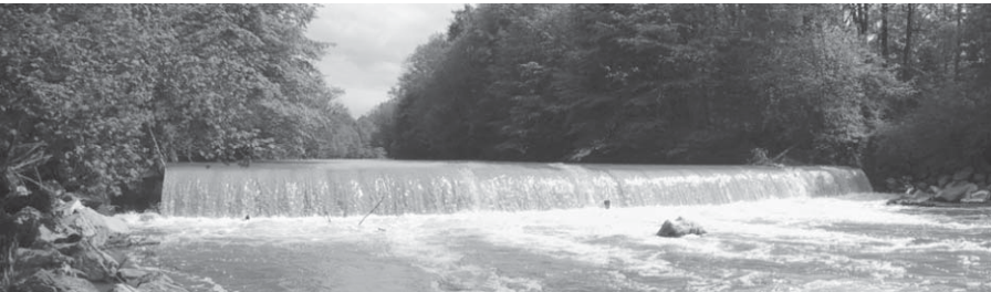
Abb. 1 Absturz mit \Delta z = 2 m bei Emme-Flusskilometer 22.000, Fließrichtung von hinten nach vorne Fig. 1 Drop with \Delta z = 2 m at Emme-River kilometer 22.000, flow direction from the rear forward
