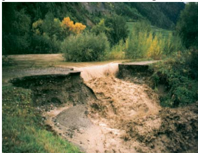
Fig. 1: Brèche ouverte dans une digue du Rhône à Chamoson, octobre 2000
