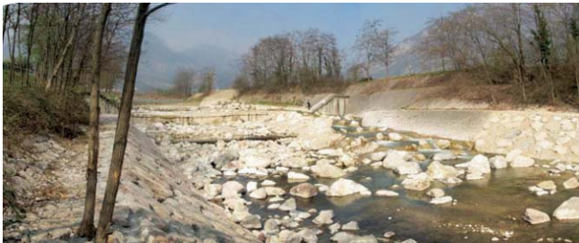
Fig. 9: Scala di risalita per i pesci sul fiume Sarca a valle di Arco, realizzata nel 2002
