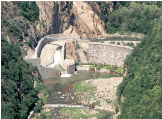
Fig. 2: Serra di S. Giorgio a lavori ultimati (1989)
