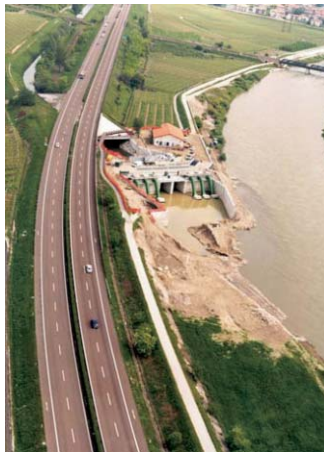
Fig. 6: Impianto idrovoro durante la fase di costruzione
