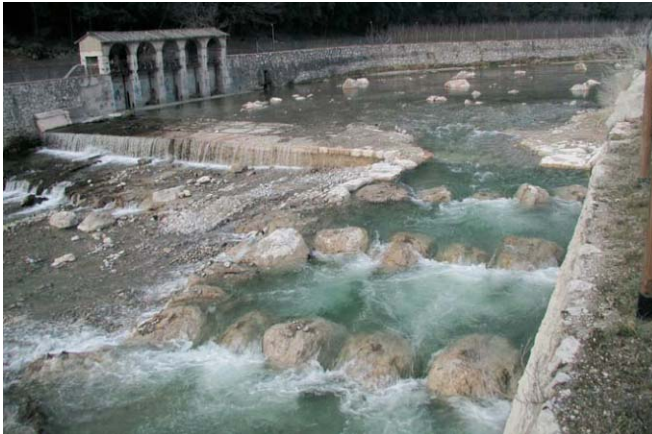
Fig. 8: Scala di risalita per i pesci sul fiume Sarca a monte di Arco, realizzata nel 2001
