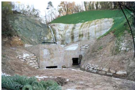
Fig. 4: Opera di presa del rio dell'Asen a fine lavori Fig. 4: Intake of the brook "Rio dell'Asen" at work completed
