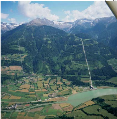
Abb3: Kraftwerk Malta Hauptstufe Fig3: Malta powerplant, main installation
