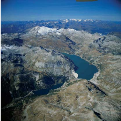
Abb2: Kraftwerk Malta Oberstufe Fig2: Malta powerplant, upper installation
