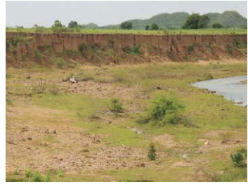
Abb.3 Senkrechter Uferhang mit Rillenerosion Fig.3 Vertical bank cliff with rill erosion
