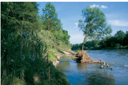
Abb. 7: Seitenerosion nach Entfernung der Ufersicherung innerhalb zwei Jahren
