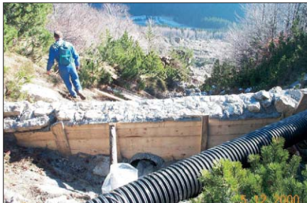
Fig. 13., 14: The Slovenian Air Force helped with helicopters; Draining of the landslide (Photo: B. Ušeničnik); Abb. 13, 14: Slowenische Luftkraft half mit dem Hubschrauber; Dränierung des Hinterlandwasser
