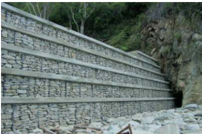
Fig4: Dam in torrent El Cojo. (2003)
