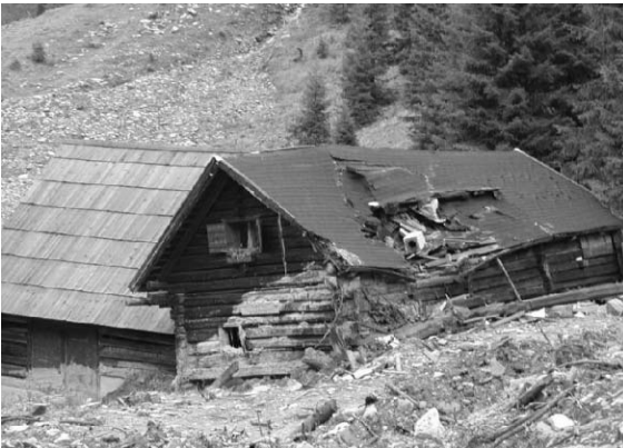
Abb. 2: Moaralm nach dem Murenereignis vom Juli 1999 Fig. 2: Moaralm-hut after the debris flow event in July 1999
