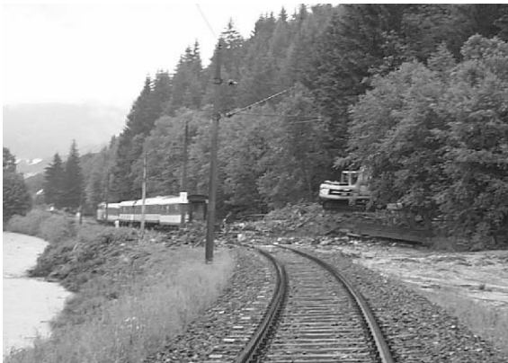
Abb. 3: Vermurung der Ennstalstrecke der Österr. Bundesbahnen und entgleister Regionalzug im Mündungsbereich des Schlattenbaches in die Enns im Juni 2000 (Foto WLW)
