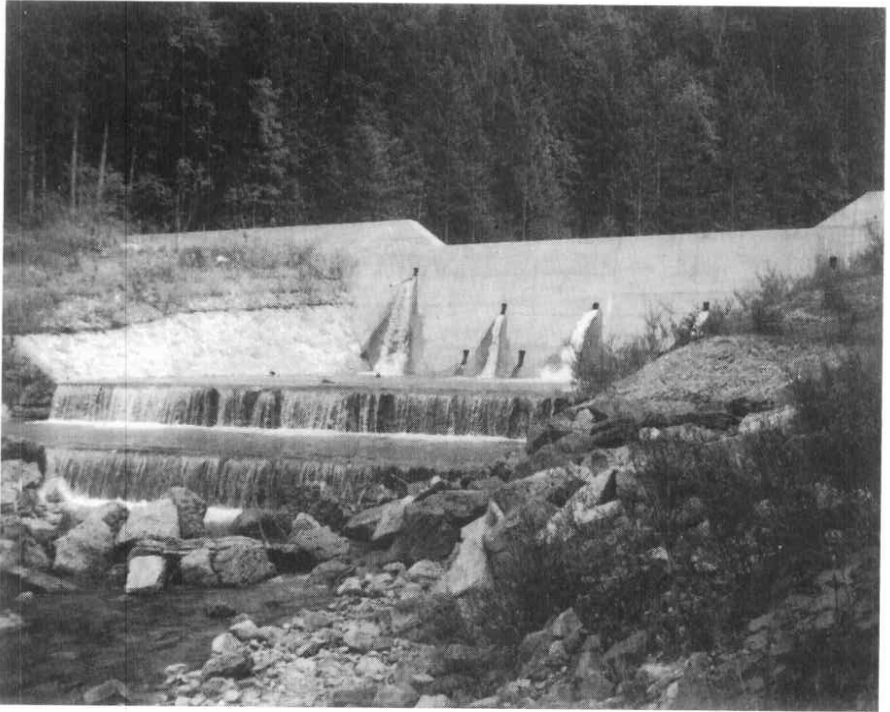
Bild 5: Geschieberückhaltesperre am Jenbach
