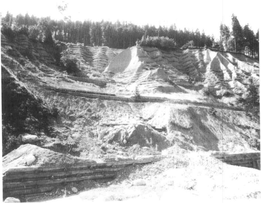
Bild 6: Lebendbau am Weißengraben bei Ruhpolding
