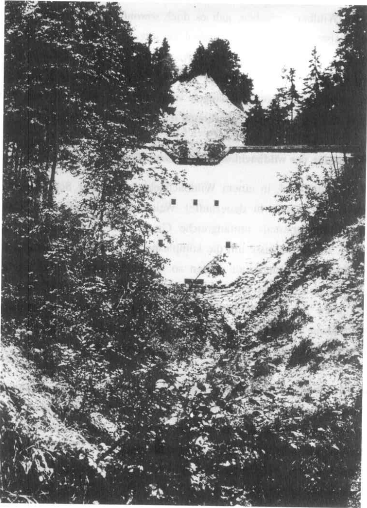
Bild 8: Konsolidierungssperre am Hirschbach bei Lenggries
